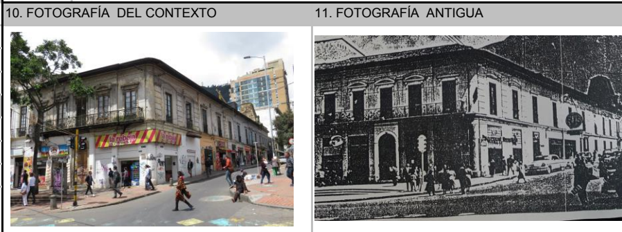
Fuente: Equipo Fotografía PEMP Patrimonio Inmueble
