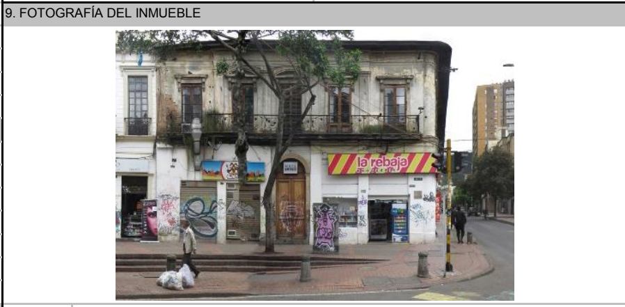
Fuente: Equipo Fotografía PEMP Patrimonio Inmueble
